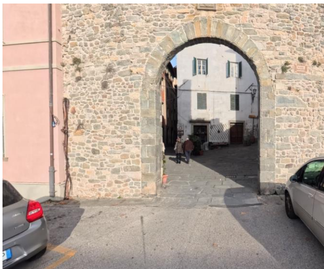
Figura 11 ingresso Porta Reale
