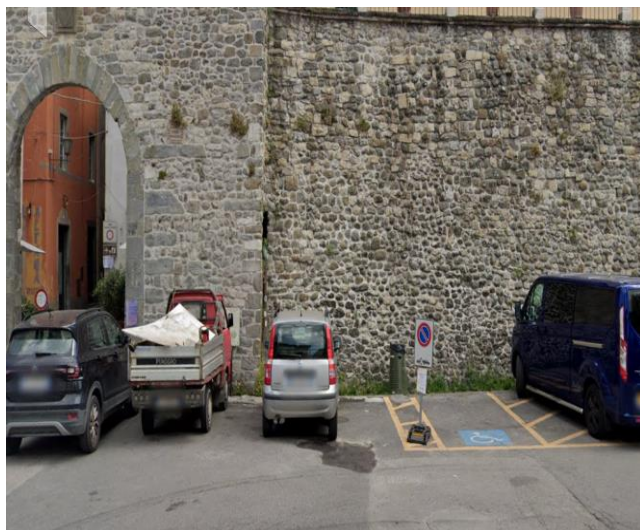
Figura 8 Parcheggio del Fosso, Via Marconi
